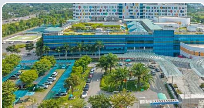
Công Trình lợp mái nhà xe bệnh viện nhi đồng 3
